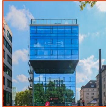
Upper Eastend (Tower) Schwedlerstraße 8 60314 Frankfurt am Main
