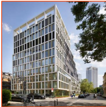
MORROW Oberlindau 54-56 60323 Frankfurt am Main
