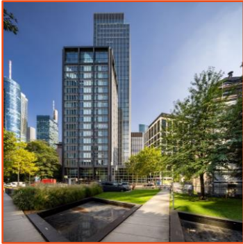
T11 Tanusanlage 11 60329 Frankfurt am Main
